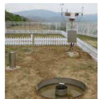
某系统刚安装后
